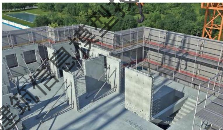
图 3-51 预制构件吊装模拟
